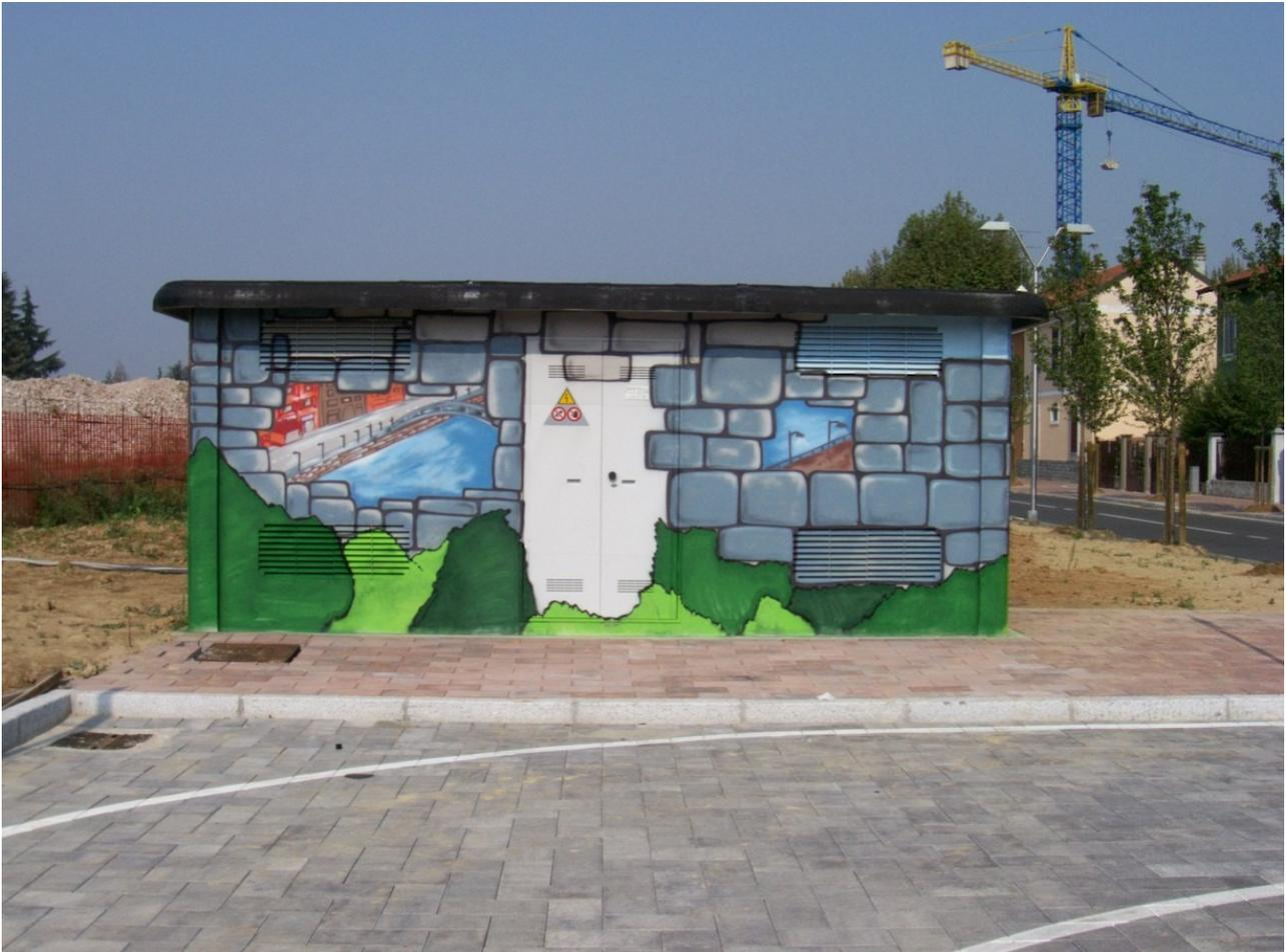
*Cabina Secondaria (CS) di trasformazione – La potenza elettrica viene trasformata da Media Tensione (MT) a Bassa Tensione (BT)*
