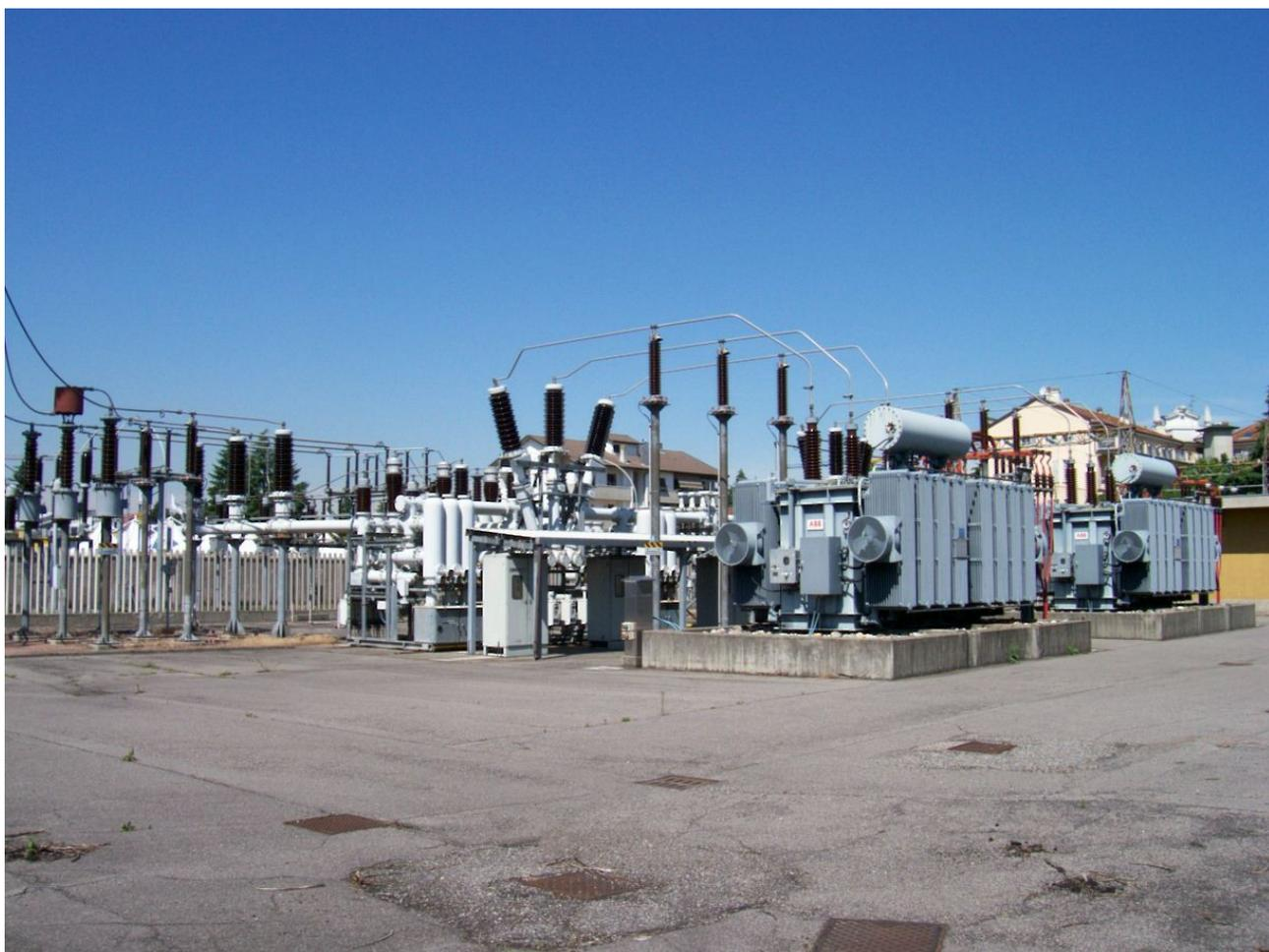
*Cabina Primaria (CP) di trasformazione – La potenza elettrica viene trasformata da Alta Tensione (AT) a Media Tensione (MT)*
